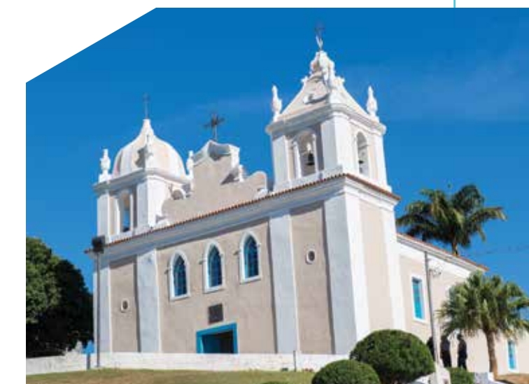
Igreja Nossa Senhora da Conceição, em Viana, após a restauração realizada pelo Instituto Sincades
