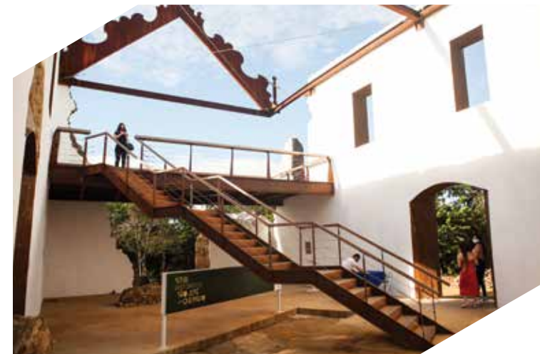
As ruínas de São José do Queimado, na Serra, foram reformadas em 2020 com apoio financeiro do Sincades
